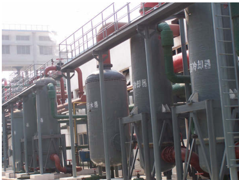
Figure 2-5 Usine de production de chlorure de vinyle monomère en Chine
